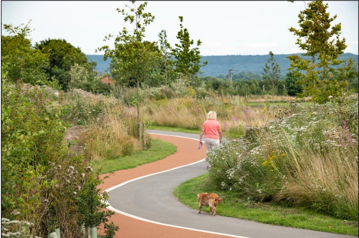
Abbildung 71 Sowerby Park and Sports Village, Großbritannien - Vorbildliche Aufwertung von Rad- und Fußwegen. Die Trennung des Rad- und Fußweges wird durch Farbe optisch hervorgehoben. Blühwiesen flankieren die Wege und bieten nicht nur eine ästhetische, sondern auch eine klimatische und biologische Aufwertung. (Foto: ©Simon Vine 51 )
